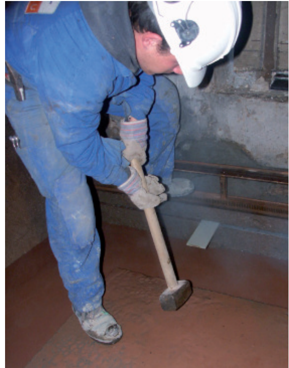
Um eine Setzung zu verhindern und die Tragfähigkeit nicht zu beeinträchtigen, wurden nach Einbau der Isolation in regelmäßigen Abständen Keilplatten aus Kunststoff in die Sägefuge eingeschlagen. Danach wurde der Sägeschnitt mit sulfatbeständigem Quellmörtel verpresst und verputzt. Fotos: Jörg GmbH
