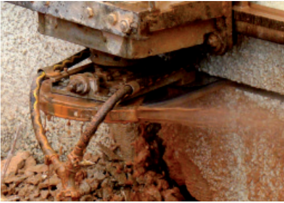
Mit der Diamantkettensäge können Materialien aller Art – von Altbeton bis Felsgestein – bis zu einer Stärke von 1,40 Meter gesägt werden. Die spezielle Säge wird von der Jörg GmbH laufend weiter entwickelt.
