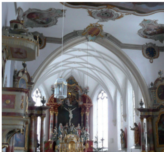
Der Sakralbau aus dem frühen 16. Jahrhundert steht unter strengen Denkmalschutzauflagen. Vor allem das Gewicht des gotischen Kreuzrippengewölbes musste während der Arbeiten abgefangen werden.
