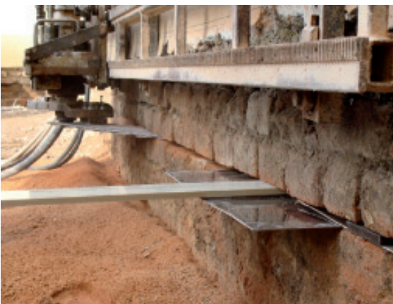
Die Wahl der Isolierplatte hängt vom Mauerwerk ab: Für Bereiche, in denen große Schubkräfte wirken, werden besandete Chromstahlbleche verwendet, da durch die Beschichtung der Reibungskoeffizient deutlich erhöht wird. Die Platten werden vorab zugeschnitten und überlappend eingesetzt.
